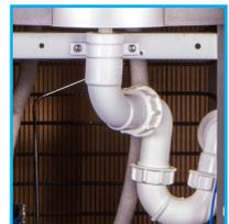
Ein Abwasseranschluss-system mit Pumpe pumpt das Abwasser aus der Tropfschale über eine Entfernung von 100 m und eine Steigung von 5 m (Werkseitig montiert).
